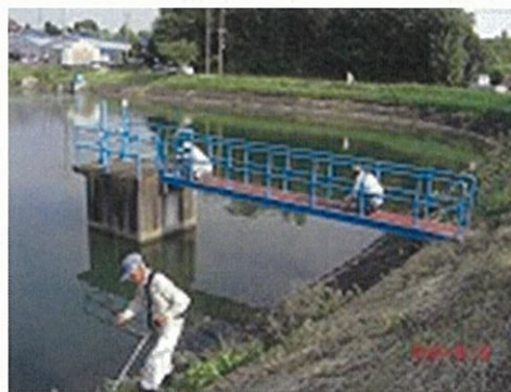
ため池の定期的な清掃・修繕
