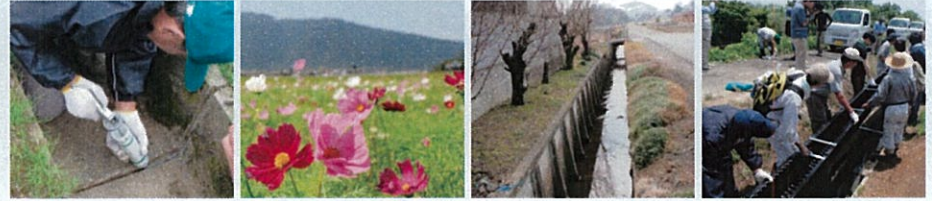
水路の目地補修 植栽による景観形成 水路の更新 水田魚道の設置
