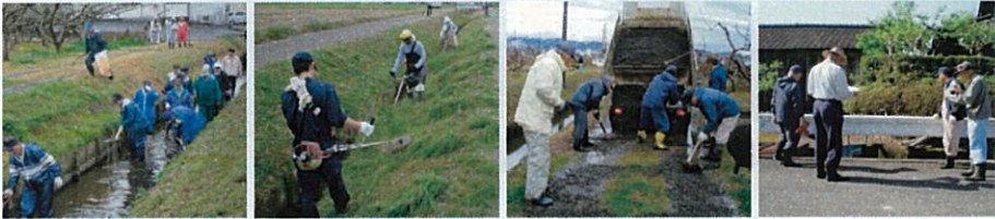
水路の泥上げ 水路の草刈り 農道の路面維持 施設の点検
