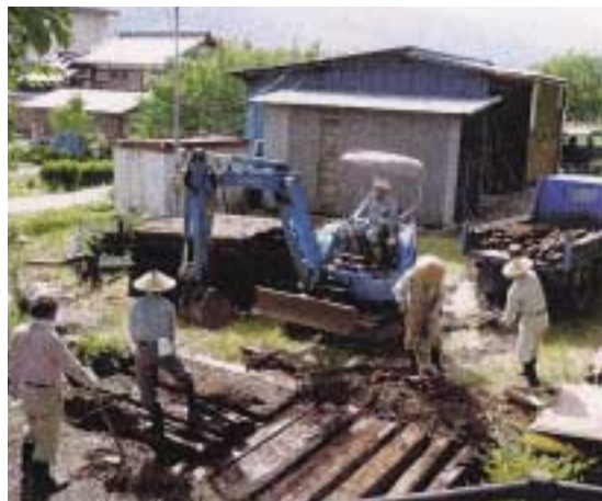
川西南部ふるさと守り隊(下呂市萩原町) 老朽化した農道の橋を枕木を使って架け替え
