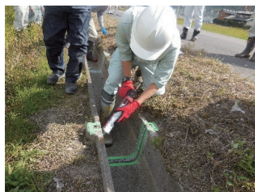
シーリング剤注入
