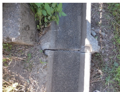
清掃後の目地
