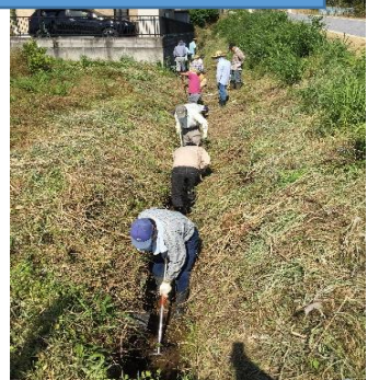
排水路土砂上げ
