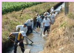
水路の泥上げ
