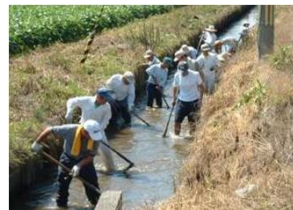
水路の泥上げ
