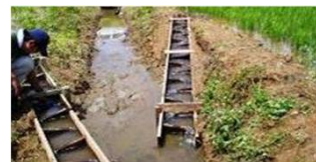
水田魚道の設置
