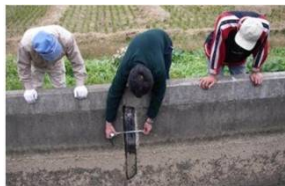
施設の機能診断
