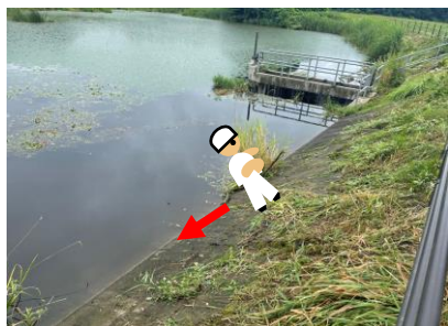
(ため池堤体の急傾斜)
