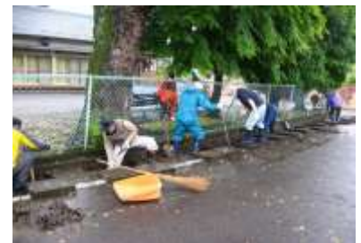
水路の泥上げ作業(7月2日)
