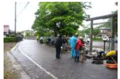
水路の泥上げ作業(7月2日)
