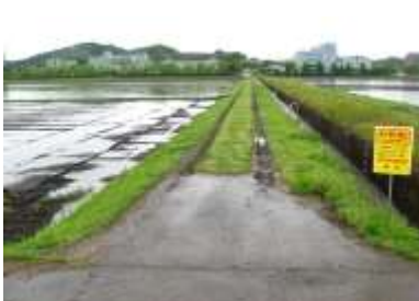
農業施設の点検(4月30日)
