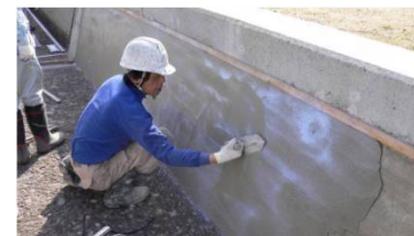
老朽化した水路壁のコーティング
