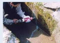
水路のひび割れ補修
