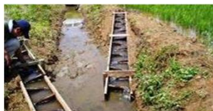
水田魚道の設置
