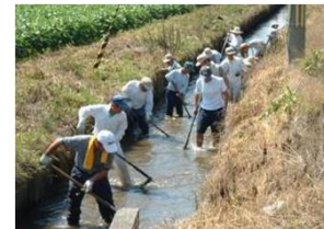
水路の泥上げ
