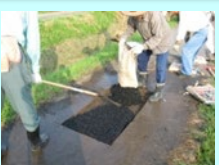
農道の部分補修
