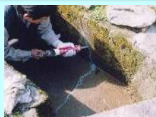
水路のひび割れ補修
