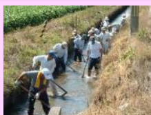
水路の泥上げ
