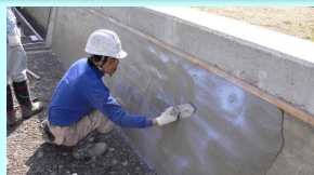
老朽化した水路壁のコーティング
