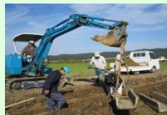
コンクリート水路の更新
