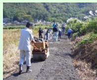
未舗装農道の舗装
