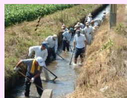
水路の泥上げ
