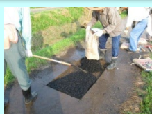
農道の部分補修
