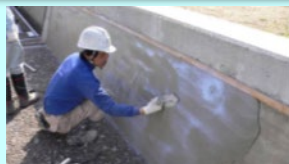
老朽化した水路壁のコーティング
