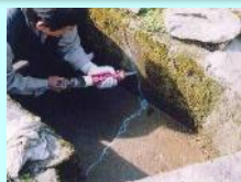
水路のひび割れ補修
