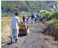
未舗装農道の舗装
