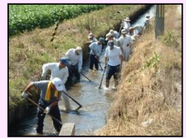
水路の泥上げ
