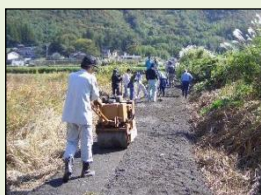
未舗装農道の舗装
