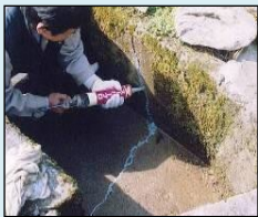
ひび割れの補修
