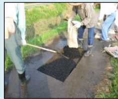
農道の部分補修
