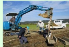
コンクリート水路の更新
