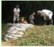
漏水箇所の補修
