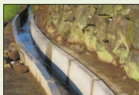
素堀り水路からの更新
