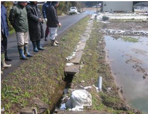
開水路の点検状況
