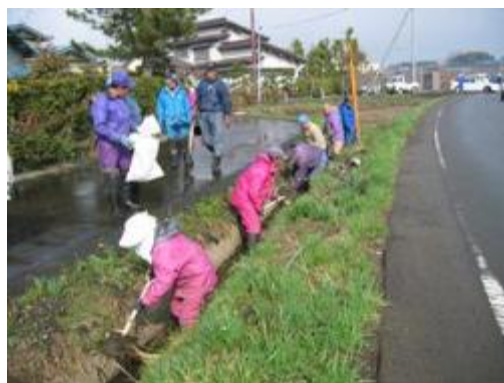
側溝の泥上げ
