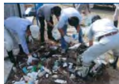
ゴミ・土砂の除去状況
