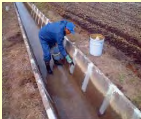
目地詰め作業
