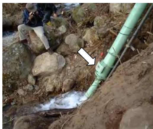
簡易な発電機（図の矢印）
