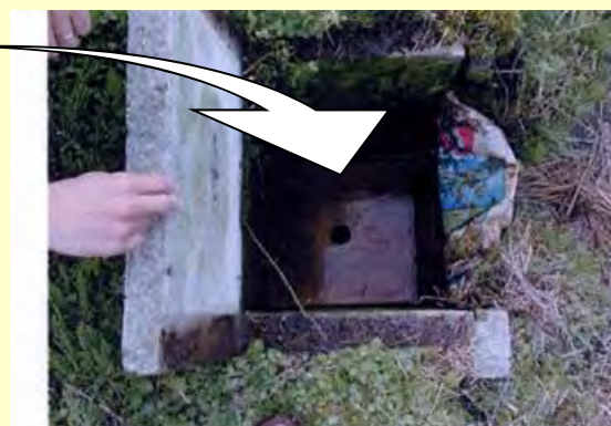
排水調整板設置状況
