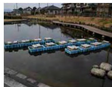
木炭浄化（接触酸化法の一つ）
