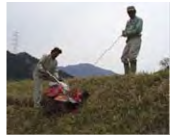
小段設置状況（掘削）
