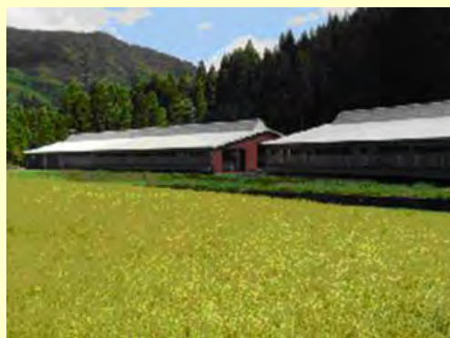
たい肥プラントの外観
