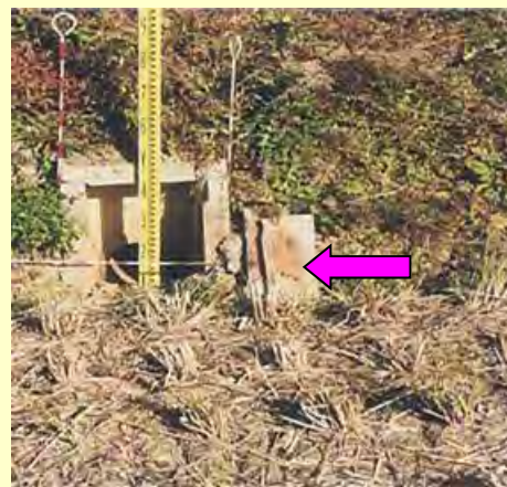
排水調整板設置状況
