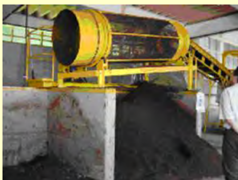
堆肥プラント
