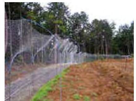
防護柵設置状況
