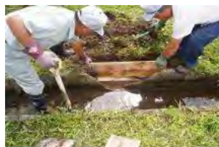
U字溝の改修作業
