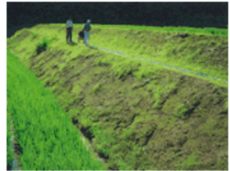
小段（犬走り）設置後の法面
