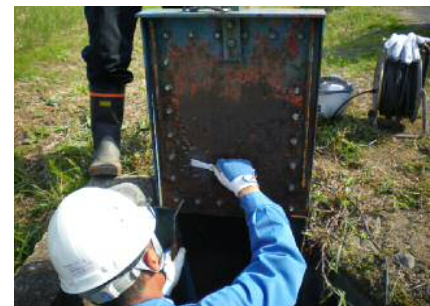
ゲートの補修状況
