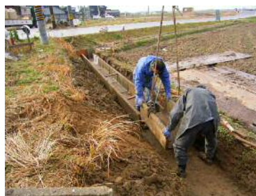
水路の再布設
