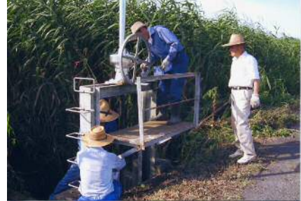
ゲートの点検
