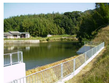
金網フェンスの 設置状況
