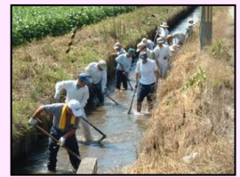
水路の泥上げ
