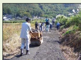
未舗装農道の舗装
