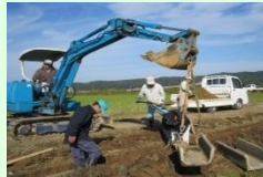
コンクリート水路の更新
