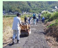
未舗装農道の舗装
