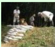
漏水箇所の補修
