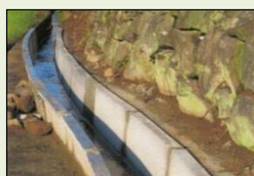
素堀り水路からの更新
