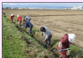
水路の泥上げ
