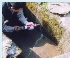
ひび割れの補修
