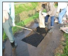
農道の部分補修
