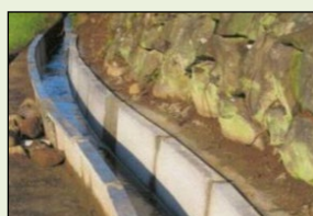
素堀り水路からの更新
