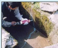
ひび割れの補修
