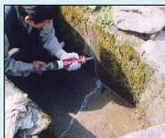
ひび割れの補修
