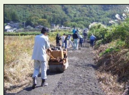
未舗装農道の舗装
